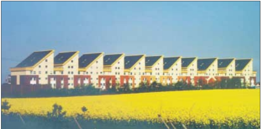
Abbildung 5: Ausgeführte Solar/ Wärmespeicheran- lage Rostock- Brinckmanshöhe
