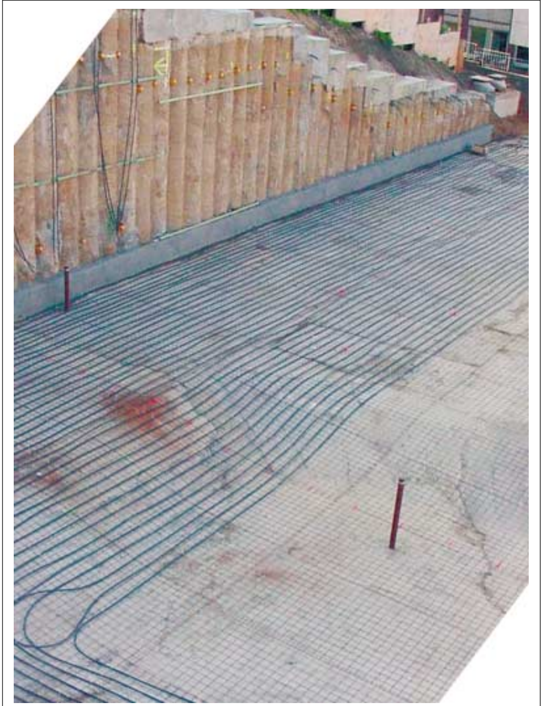
Abbildung 5: Flächenkollektor und Bohrpfahlwand beim Neubau der IHK Kiel (Foto: Dr.- Ing. Bernd Kriegel Ingenieure GmbH, Kiel)
