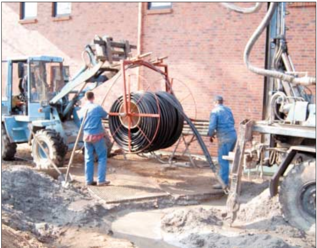
Abbildung 5: Einbau der Erdwärmesonden (Foto: Thomas Liebsch- Dörschner)
