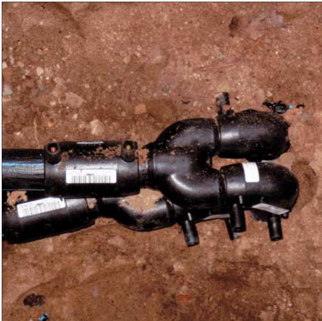
Abbildung 6: Anschluss Sonden- kopf (Foto: Tho- mas Liebsch-Dör- schner)
