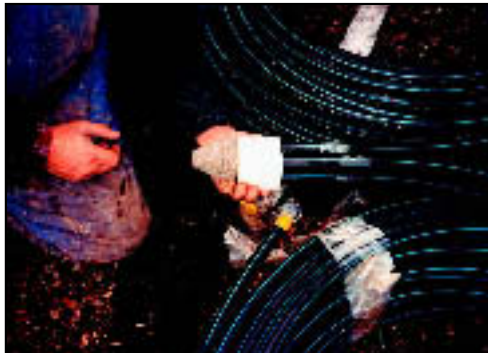
Abbildung 7b: Erdwärmetauscher als Doppel-U-Rohr aus flexiblem Kunststoff (Photos: P.-F. Schenck)
