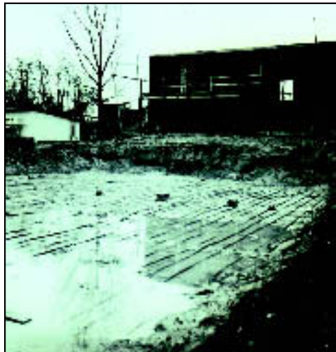
Abbildung 3a und b: Verlegung von Erd- wärmetauschern (Photos: W. Storm).
