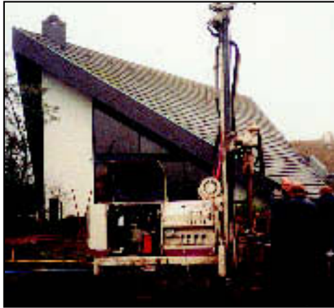
Abbildung 7a: umweltschonendes Bohren zur Installa- tion einer vertikalen Erdwärme- sonde
