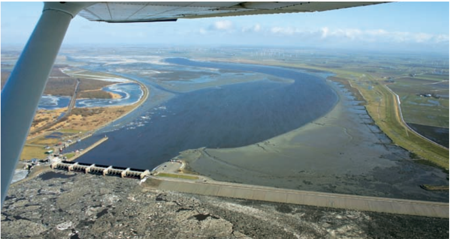
Abb. 22: Eidersperrwerk März 2010 (LLUR)
