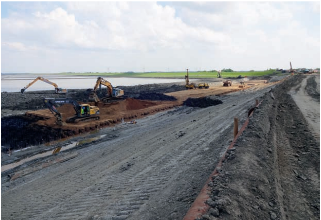
Abb. 13: Deichverstärkung Alter Koog Nordstrand (LKN)
