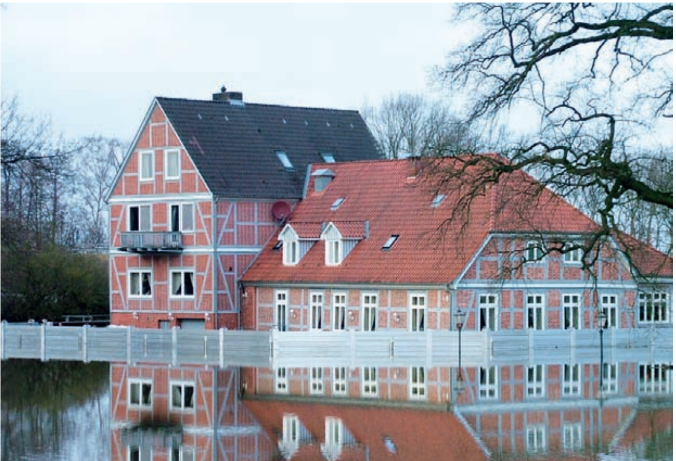
Abb. 15: Elbehochwasser 2011 - Objektschutz Palmschleuse Lauenburg (MELUR)
