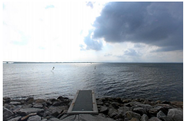
Abb. 16: Seedeich: Deichsiel-Auslaufbauwerk bei ca. Kkm 0,91, Blickrichtung Süd LKN-SH 2008-09-24_06698 Sept. 2008
