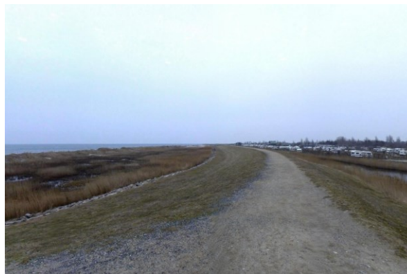
Abb. 141: Deckwerk hinter Vorland mit Strandwall bei Kkm 19,64, seeseitige Deichfußbefestigung, Blickrichtung Nord LKN-SH 2004-03-11_01081 März 2004
