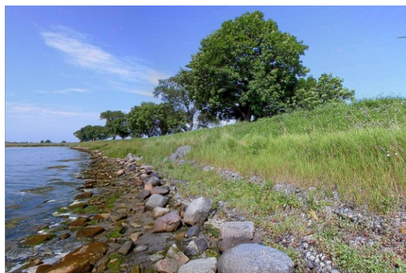
Abb. 307: Deichfuß mit Steinschüttung und Gabionensicherung bei rd. Kkm 63,94, Blickrichtung West LKN-SH 2006-07-06_03712 Juli 2003
