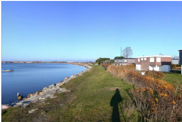
Abb. 50: Deichkrone und Fußsicherung bei ca. Kkm 5,45, Blickrichtung Nord LKN-SH 2003-11-06_00992 Nov. 2003
