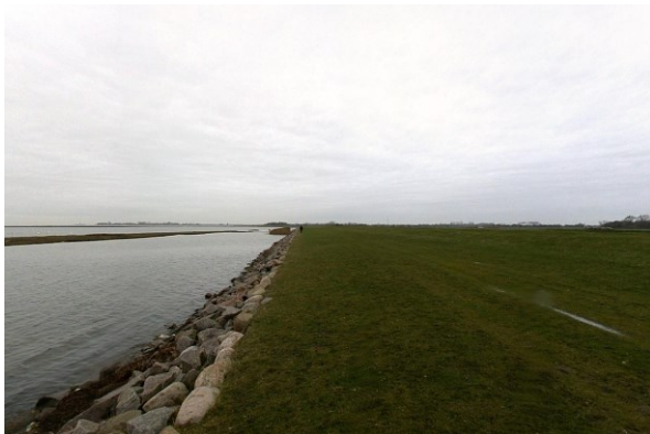
Abb. 64: Aussenberme und Fußsicherung bei ca. Kkm 7,21, Blickrichtung West LKN-SH 2003-11-20_01006 Nov. 2003
