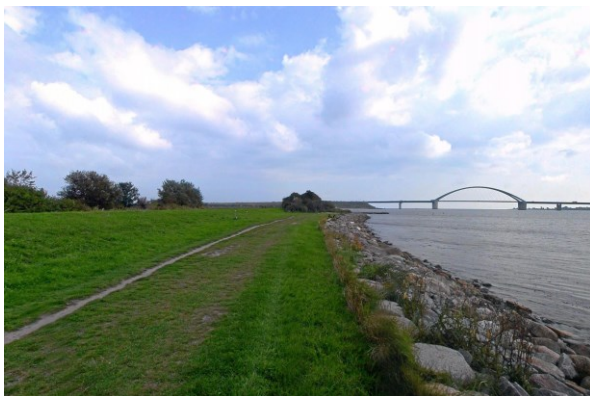
Abb. 13: Seedeich: Aussenberme und Fußsicherung bei ca. Kkm 1,03, Blickrichtung Ost LKN-SH 2008-09-24_06699 Sept. 2008
