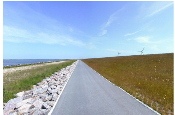
Abb. 187: Deichfußsicherung bei rd. Kkm 22,25, Blickrichtung Nord LKN-SH 2004-06-01_01536 Juni 2004
