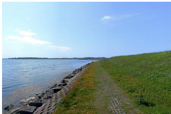
Abb. 321: Deichfußsicherung bei rd. Kkm 64,78, Blickrichtung Süd LKN-SH 2006-07-06_03726 Juli 2006
