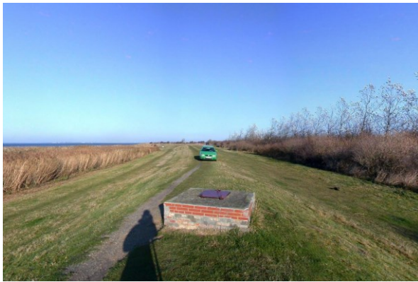
Abb. 28: Deichsiel-Kontrollschacht auf der Deichkrone bei ca. Kkm 2,30, Blickrichtung West LKN-SH 2003-11-06_00966 Nov. 2003
