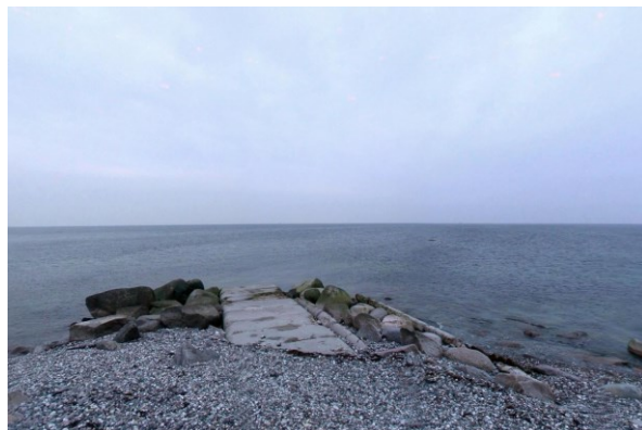
Abb. 134: Deichsiel der Kopendorfer Au bei Kkm 19,20: buhlenartiges Auslaufbauwerk, Blickrichtung West LKN-SH 2004-03-11_01075 März 2004
