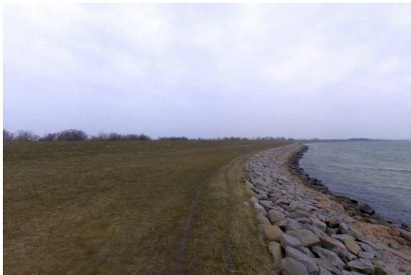
Abb. 73: Aussenberme und Fußsicherung bei ca. Kkm 8,75, Blickrichtung West LKN-SH 2004-03-11_01038 März. 2004
