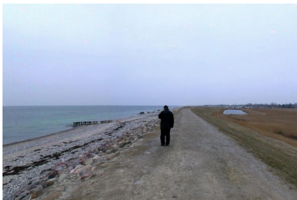
Abb. 140: Mit Deckwerk gesicherte Aussenböschung bei Kkm 19,38, Blickrichtung Nord LKN-SH 2004-03-11_01079 März 2004
