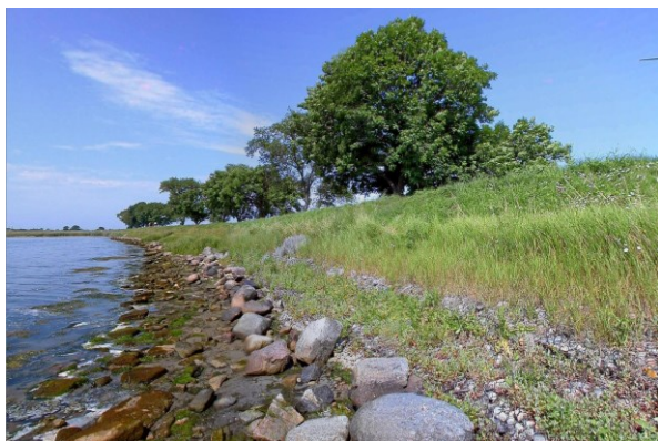
Abb. 306: Deichfuß mit Steinschüttung und Gabionensicherung bei rd. Kkm 63,94, Blickrichtung West LKN-SH 2006-07-06_03712 Juli 2003
