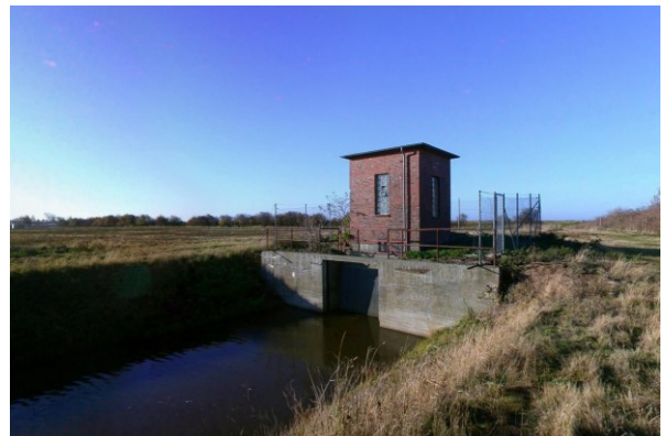
Abb. 27: Deichsiel-Einlaufbauwerk bei ca. Kkm 2,30, Blickrichtung West LKN-SH 2003-11-06_00965 Nov. 2003
