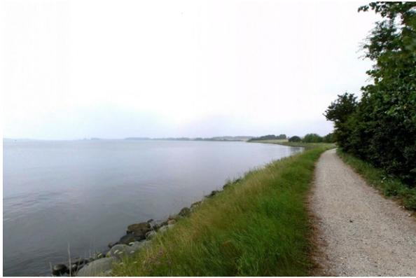
Abb. 60: Deich, Weg auf der Deichkrone und Fußsicherung bei rd. Kkm 19,58, Blickrichtung West LKN-SH 2004-08-12\_01804 August 2004
