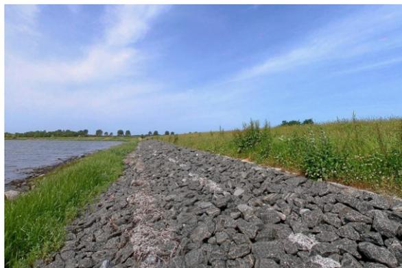
Abb. 20: Deichfußsicherung bei rd. Kkm 1,845, Blickrichtung West LKN-SH 2006-06-15\_03583 Juni 2006
