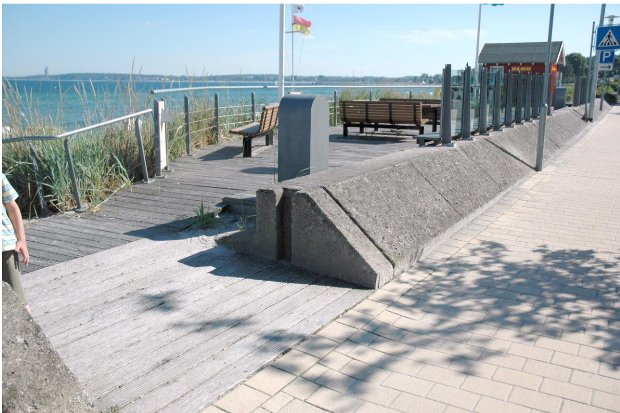
Abb. 253: HWS-Wand Sieksdorf mit ursprünglicher Stöpe und mit vorgelagertem Platz bei Kkm 308,566, Blichrichtung Süd LKN-SH 086_2011-06-27_662_N, Juni 2011
