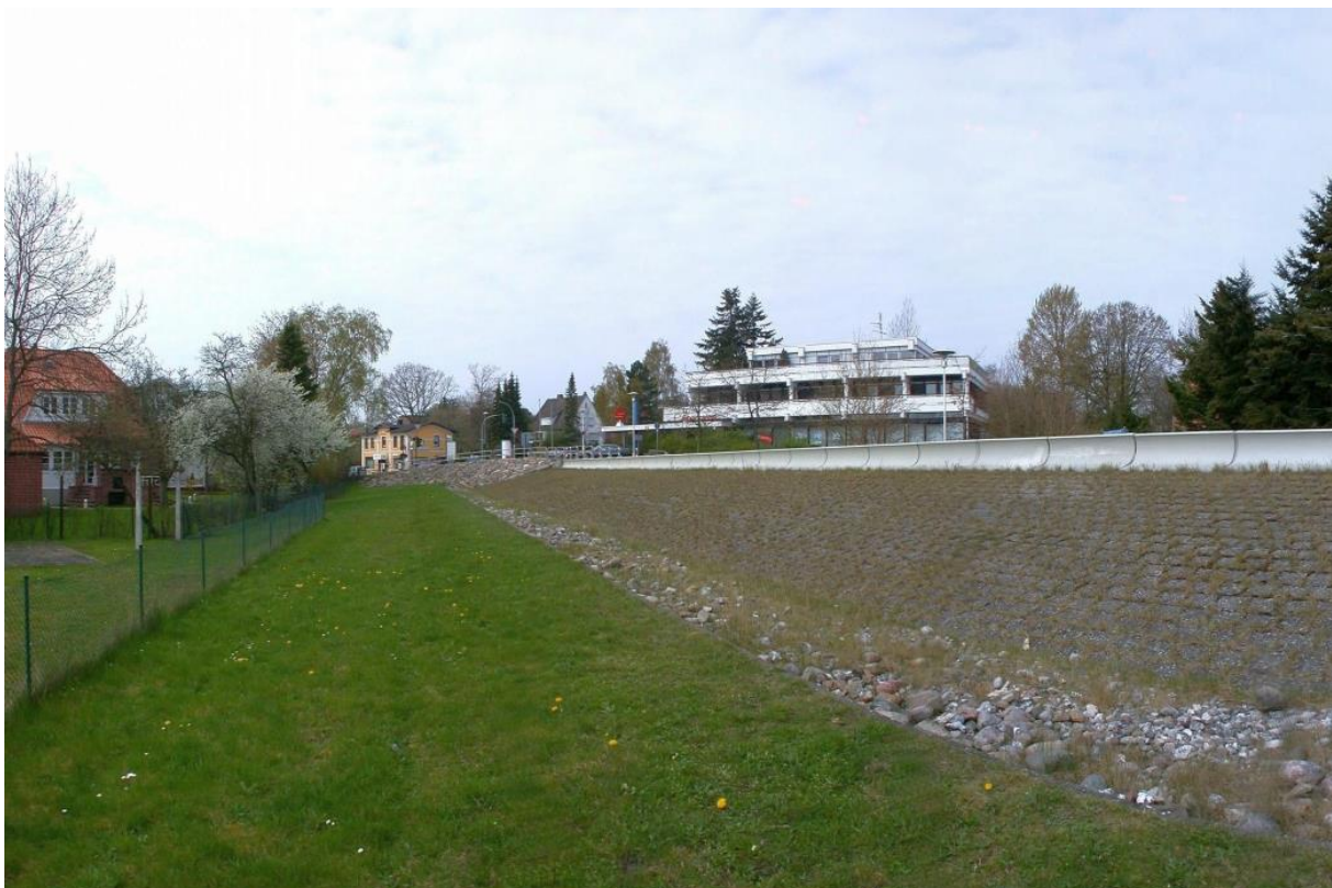
Abb. 243: Befestigte seeseitige Böschung und Deichkrone im Deckwerksbereich in Grömitz Blickrichtung Nordwest LKN-SH April 2004
