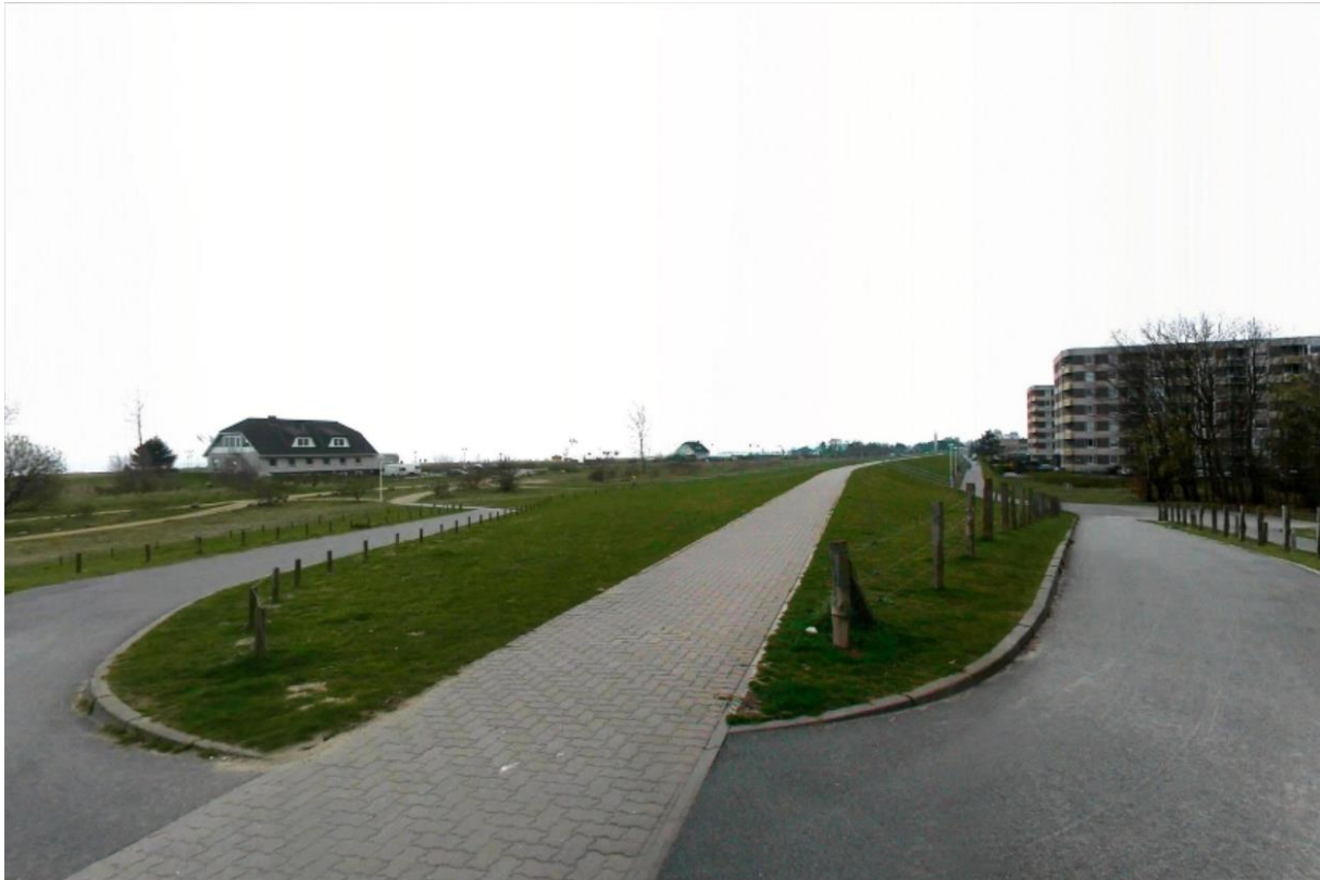
Abb. 225: Deichrampen am nördlichen Ortsrand von Grömitz Rampe bei Kkm 284,710 LKN-SH April 2004
