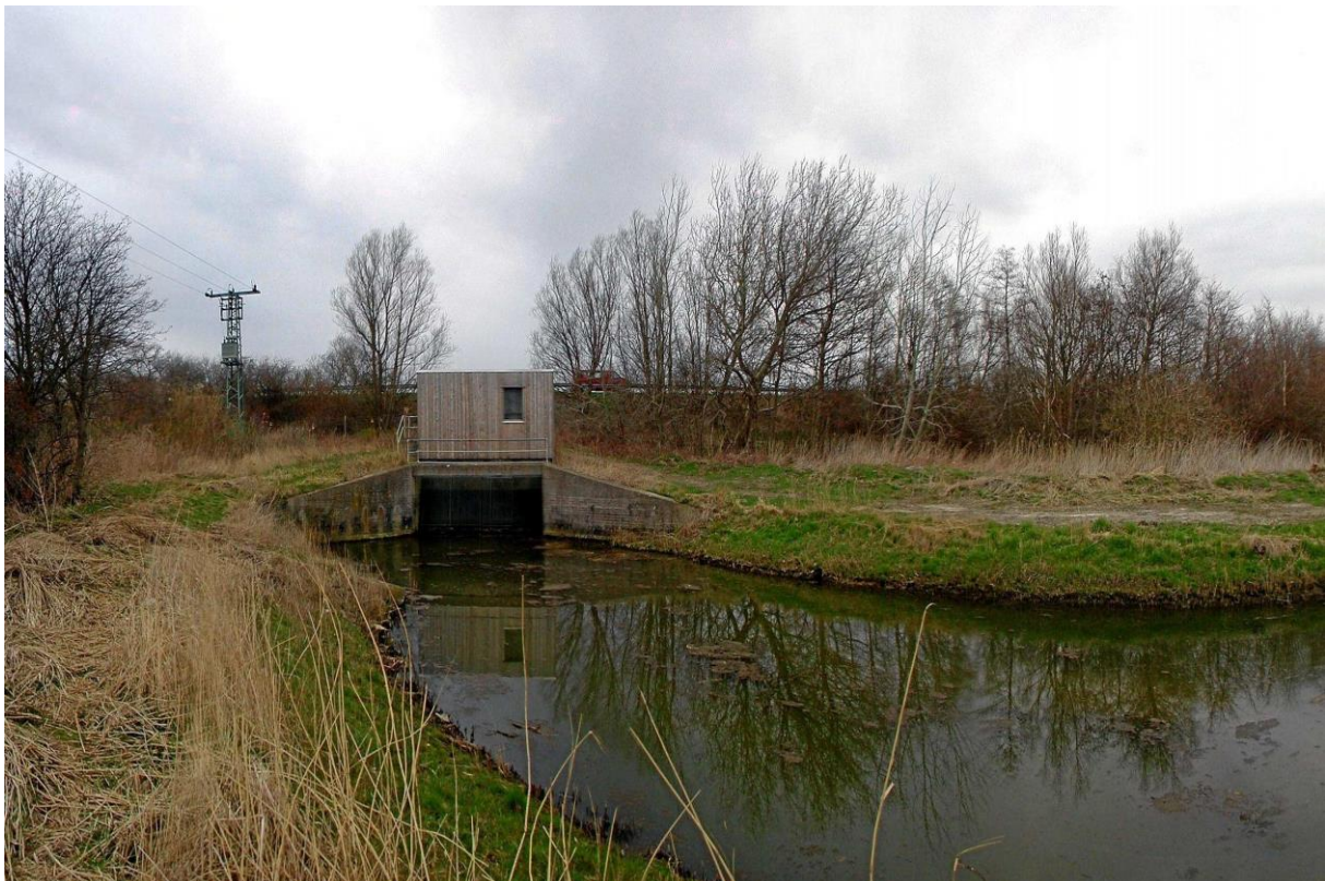
Abb. 19: Sielbauwerk-Landseite mit Schöpfwerk im Straßendamm der E4 LKN-SH 080_242779_2005-04-13_026 April
