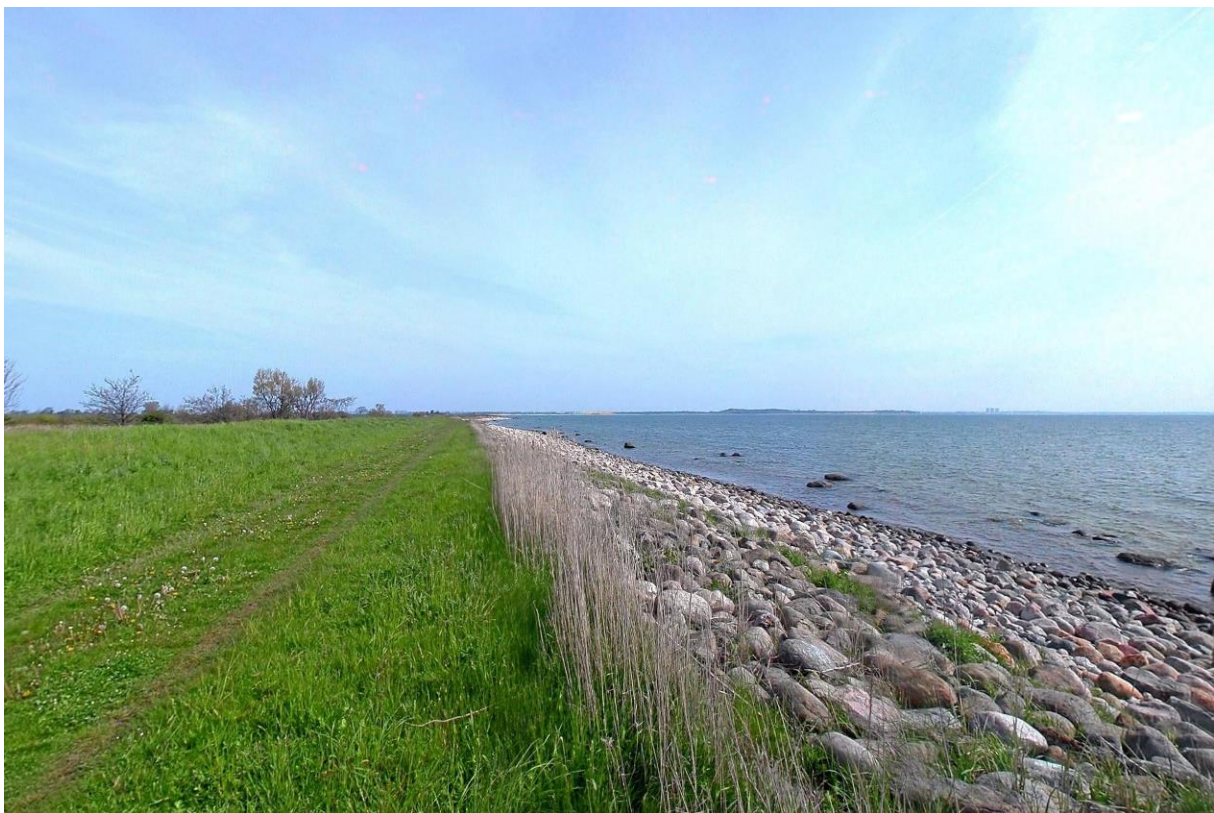
Abb. 57: Deich Großenbroder Moor, Vorland mit Deckwerk, KKm 250,584, Blickrichtung Nord, LKN-SH 2005-05-19_02482, Mai 2005
