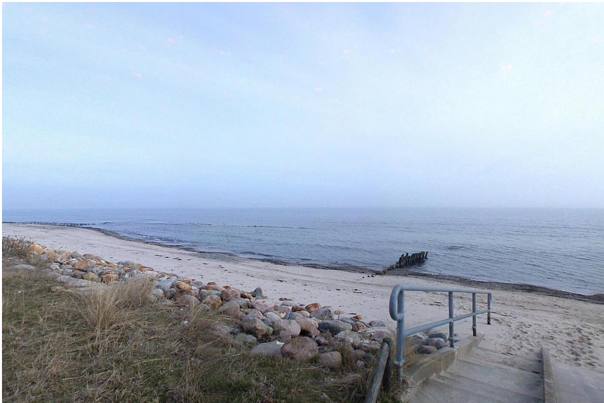
Abb. 106: Regionaldeich Süssau, Treppe und Vorlandsicherung mit Deckwerk, KKm 266,195, Blickrichtung Nordost, LKN-SH 2004-03-18_01090, März 2004
