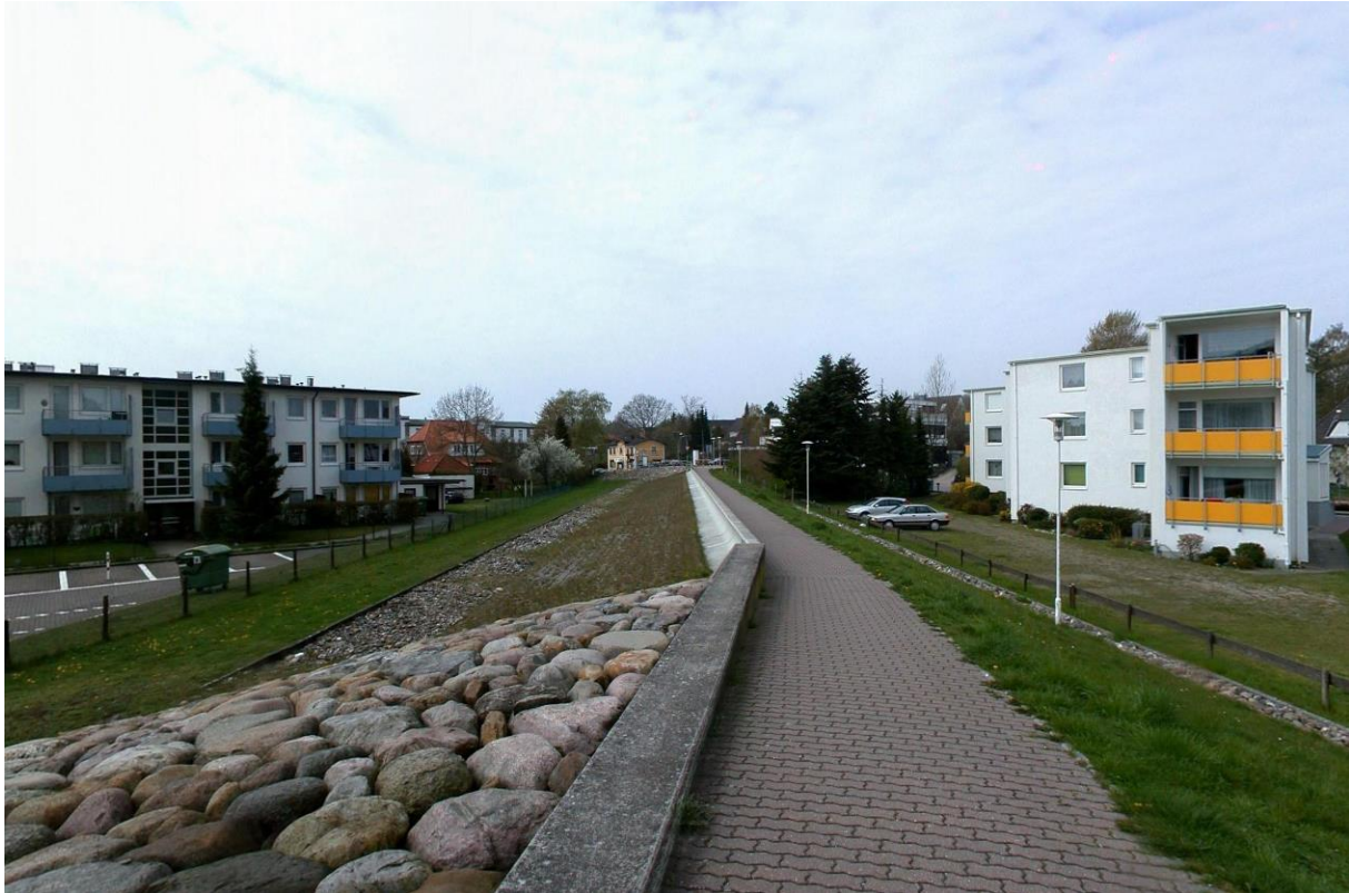
Abb. 242: Deichkrone und Wellenumkehrmauer im Deckwerksbereich in Grömitz Blickrichtung West LKN-SH 2004-04-22_01282 April 2004
