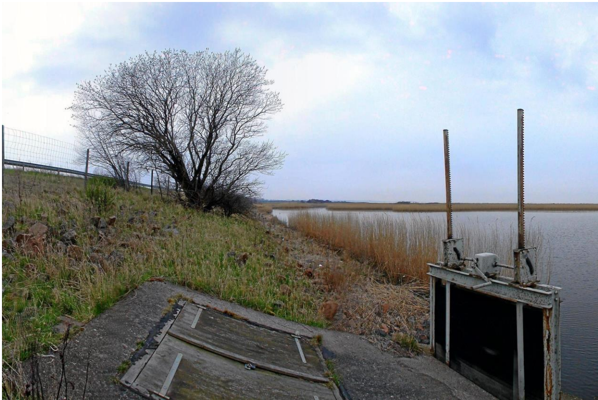
Abb. 18: Sielbauwerk-Seeseite im Straßendamm der E4 LKN-SH 080_242775_2005-04-13_032 April 2005
