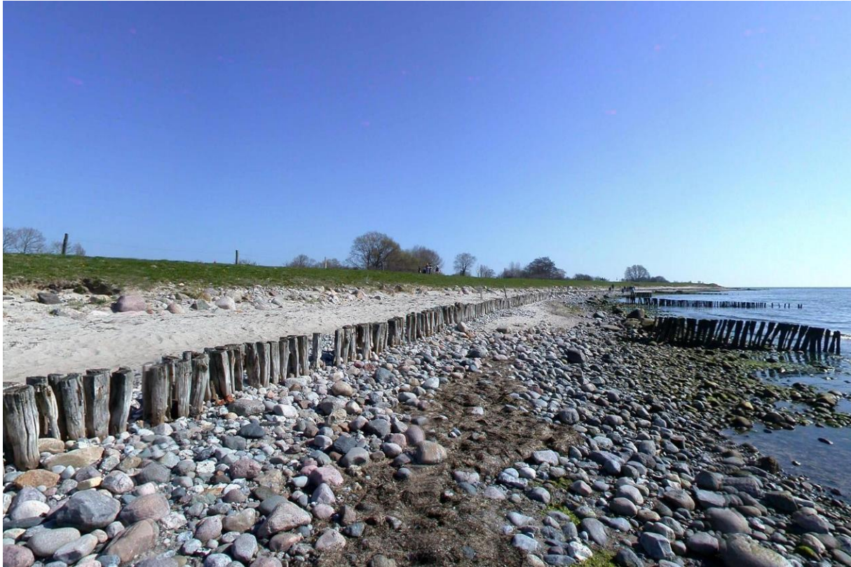
Abb. 175: Deich Dahmer Moor, Deichfuß, sog. Längsbuhne am Strand, KKm 275,98, Blickrichtung Nord, LKN-SH 2004-04-15_01221 April 2004
