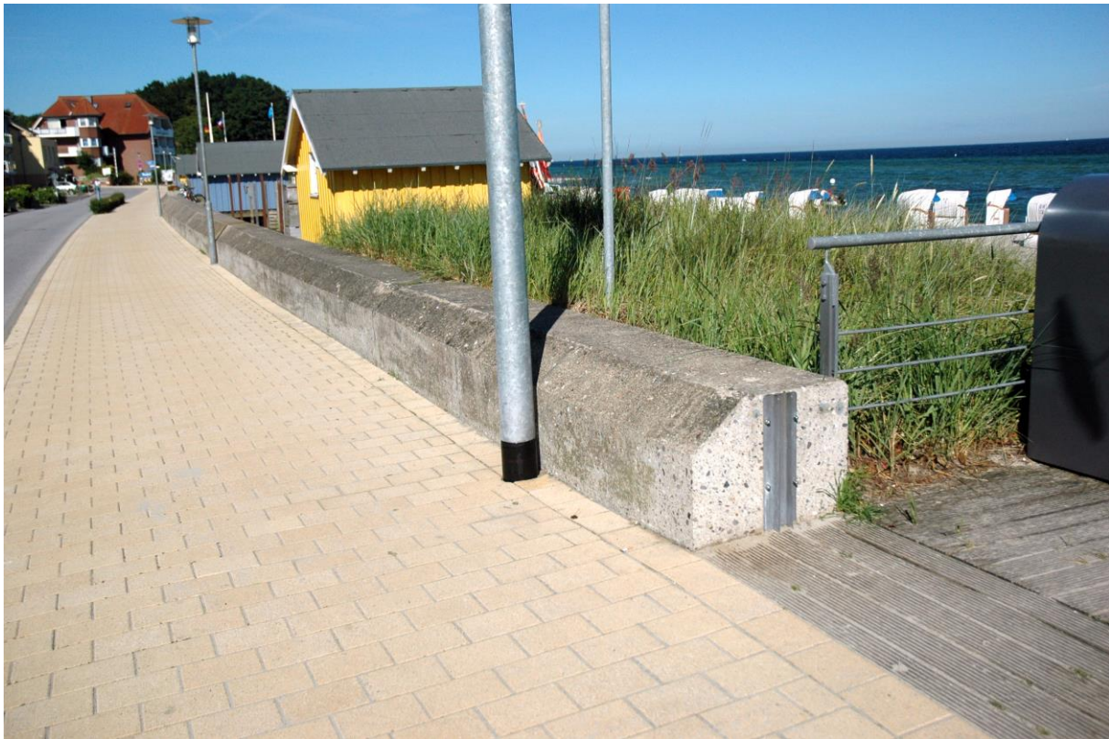
Abb. 254: HWS-Wand Sieksdorf mit neu eingebauter Stöpe und mit landseitigem Anschnitt für Fusswegverbreiterung bei Kkm 308,200, Blickrichtung Nord LKN-SH 086_2011-06-27_651_N, Juni 2011
