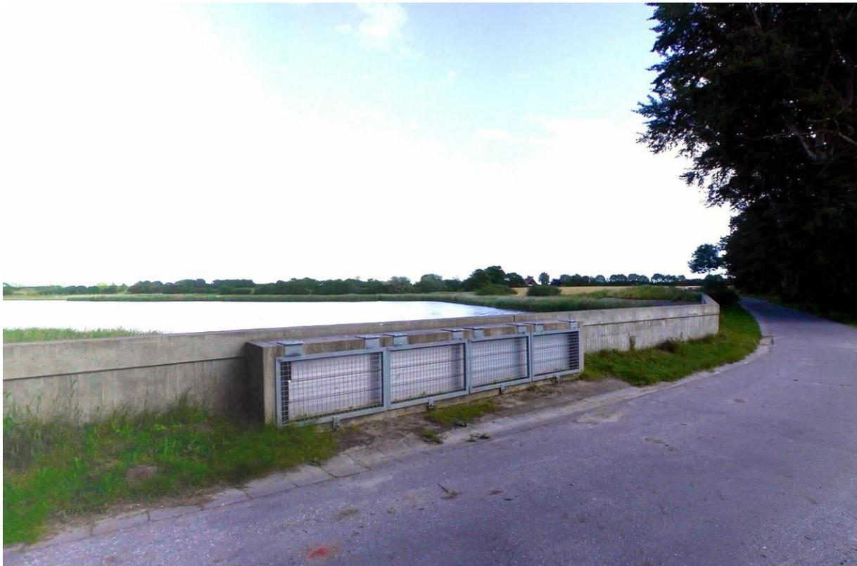
Abb. 120: Hochwasserschutzmauer und Lager für Stöpenverschluss bei rd. Kkm 56,55, Blickrichtung Ost LKN-SH 2004-07-27\_01702 Juli 2004
