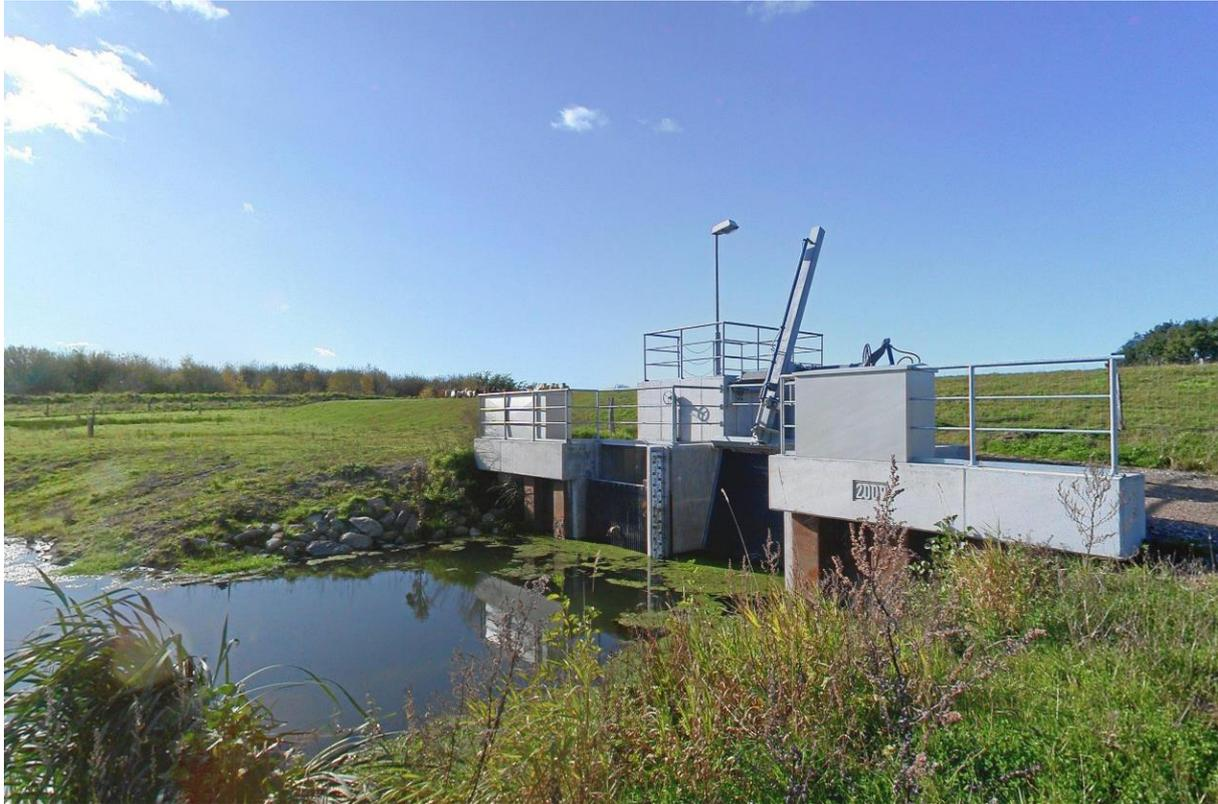
Abb. 143: Einlauf- und Notüberlaufbauwerk im Hochwasserschutz Straße Goldhöft Blickrichtung West *LKN-SH 2011-10-13\_09043*
